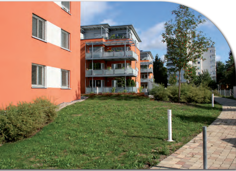
Passivhäuser, Bohnenbergstraße 2, Arnoldstraße 2 und 4
