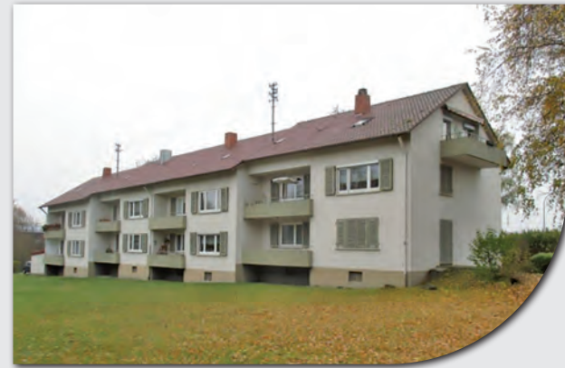
Auf Schmidten 168 vor der Sanierung
