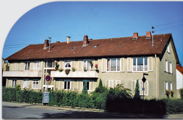
Vor der Sanierung, Längenfeldstraße 2, Johann-Sebastian-Bach-Straße 18
