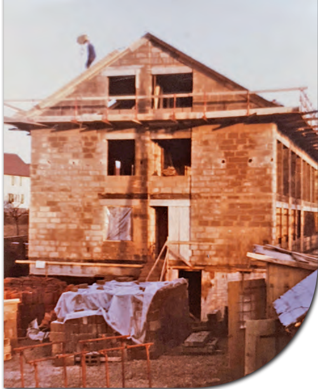
Bau des neuen Verwaltungsgebäudes in der Längenfeldstraße 21
